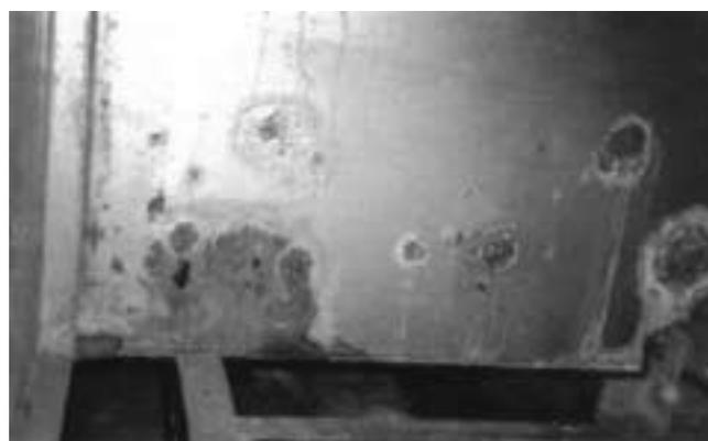
**Figura 5 : Efectos de la corrosion en el exterior de una torre**
