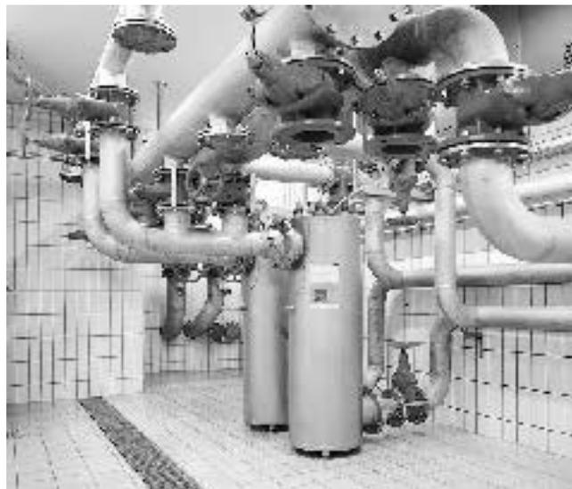
Fig. 3 - Desinfección mediante radiación ultravioleta en ACS
