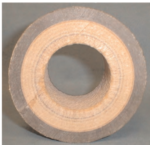
Foto 1. Tubería de agua fría con incrustaciones calcáreas
